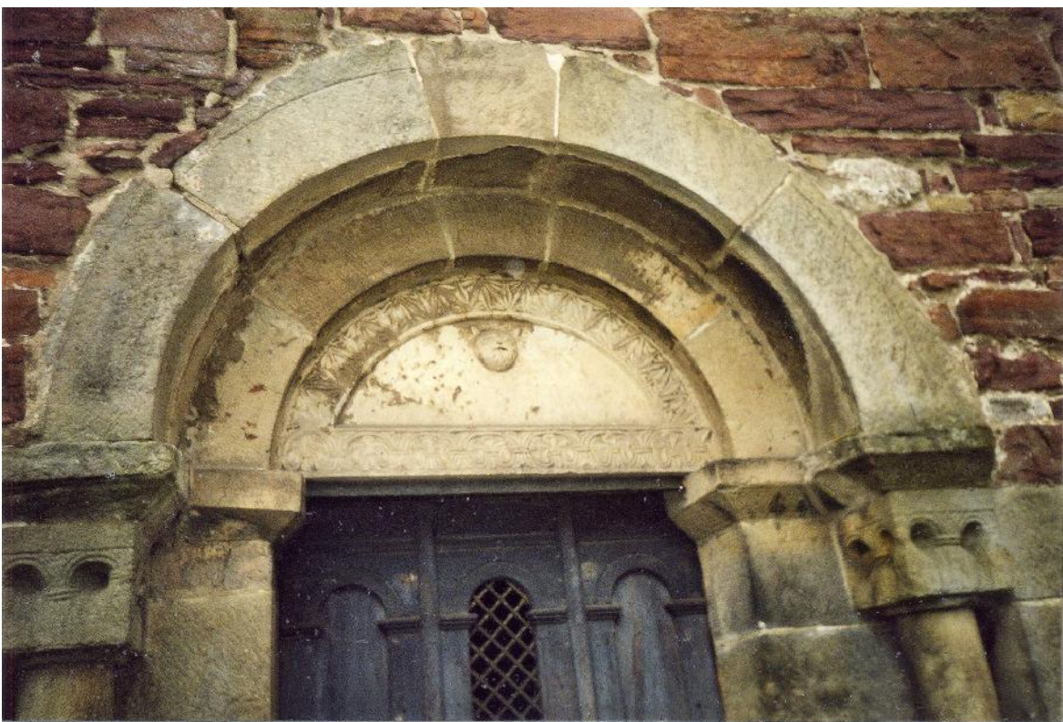
Das Tympanon der Kilianikirche in Lügde. Bis auf den Katzenkopf ist das Relief zerstört. Die Ringpalmetten entsprechen denen der „Schottenkirche“ von Regensburg
